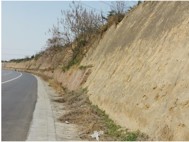
路基工程护面墙
