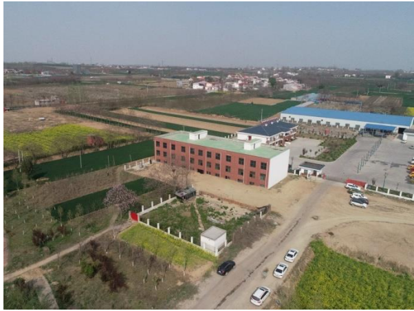
养护工区现状
