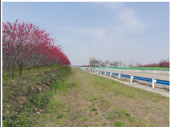
路基工程绿化
