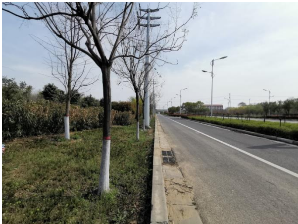
路基工程绿化
