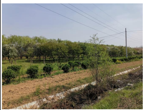
路基工程排水沟
