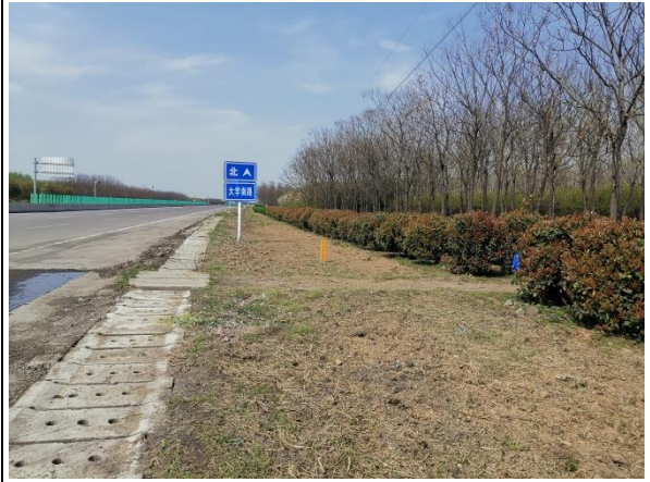
路基工程植草护坡
